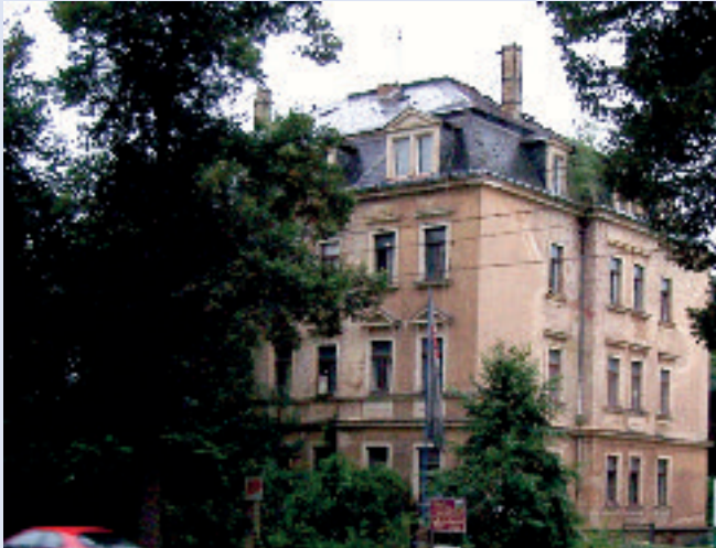
Unbewohnte, weil ruinöse Häuser, wie dieses Haus auf der Königsbrücker Straße, zählen beim offiziellen Leerstand mit
